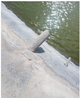
(Imagen de la Geomembrana que está en mal estado)
