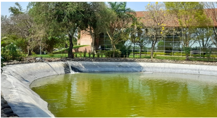
(Imagen de la Geomembrana que está en mal estado)
